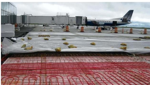
Рисунок 6. Подогрев площадок аэропорта Большой Бингемтон, Нью-Йорк, США
