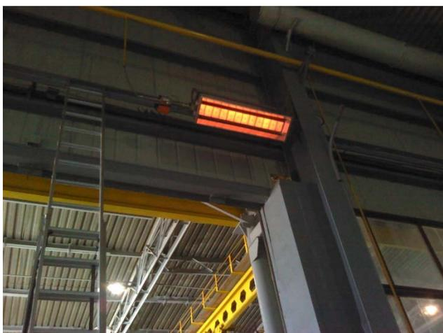
Рисунок 1 – Размещение ГИИ в промышленном цехе
